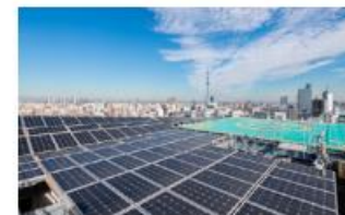
ヒューリック浅草橋ビル
