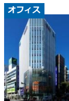
ヒューリック 新宿ビル
