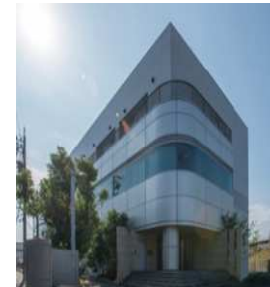
NW-04 ネットワークセンター
