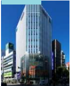
ヒューリック 新宿ビル
