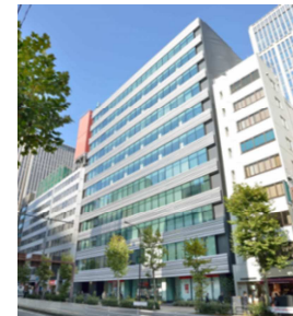
OF-14 オフィス 駅徒歩1分 ヒューリック虎ノ門ビル
