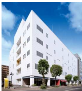
NW-07 ネットワークセンター
