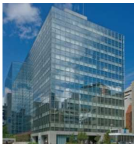
OF-02 オフィス 駅徒歩1分 ヒューリック九段ビル (底地)
