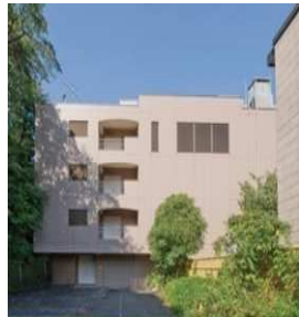
NW-02 ネットワークセンター
