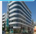
ヒューリック 東上野一丁目ビル
