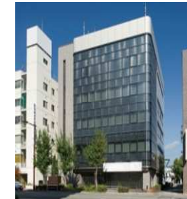
NW-05 ネットワークセンター
