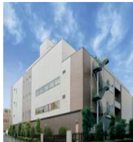
NW-01 ネットワークセンター
