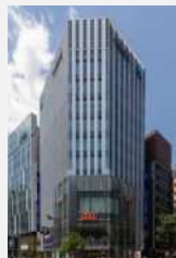
ヒューリック 新宿ビル
