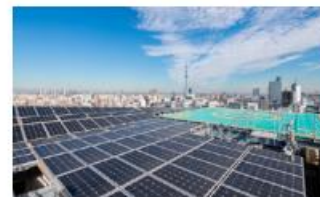
ヒューリック浅草橋ビル
