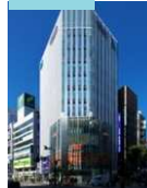
ヒューリック 新宿ビル
