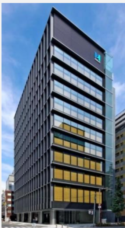
ヒューリック本社ビル
