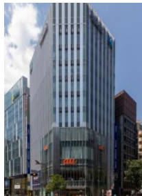
ヒューリック 新宿ビル
