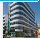
ヒューリック 東上野一丁目ビル
