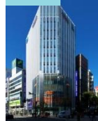
ヒューリック新宿ビル
