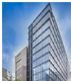
ヒューリック 銀座一丁目ビル
