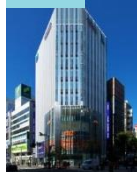
ヒューリック 新宿ビル
