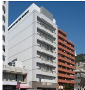
NW-03 ネットワークセンター
