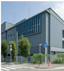
NW-08 ネットワークセンター
