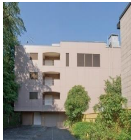
NW-02 ネットワークセンター
