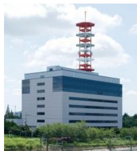
NW-06 ネットワークセンター
