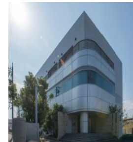
NW-04 ネットワークセンター
