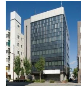
NW-05 ネットワークセンター
