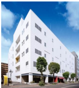
NW-07 ネットワークセンター
