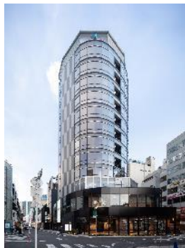
HULIC & New UDAGAWA （2021年3月竣工）
