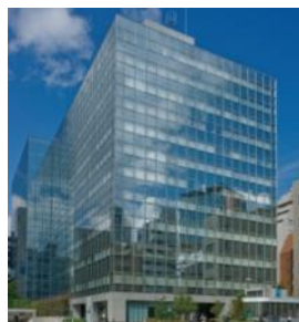
OF-02 オフィス 駅徒歩1分 ヒューリック九段ビル（底地）
