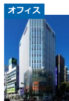
ヒューリック 新宿ビル
