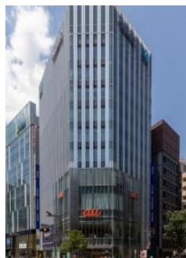
ヒューリック 新宿ビル
