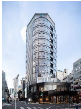
HULIC &New UDAGAWA （2021年3月竣工）
