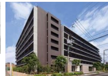
アリスタージュ経堂 （2012年5月竣工）
