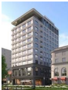
ザ・ゲートホテル横浜 by HULIC (2025年2月26日開業予定)
