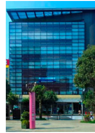
ヒューリック 八王子ビル
