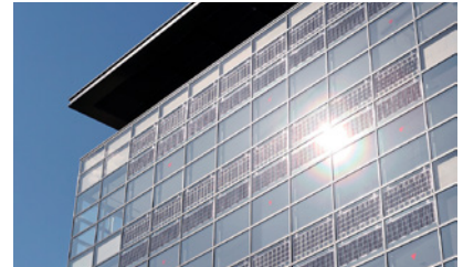
ヒューリック八王子ビル
