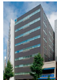
ヒューリック 神田ビル
