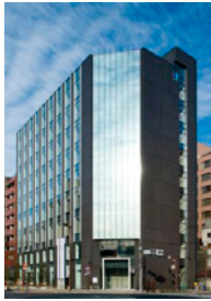
ヒューリック 両国ビル
