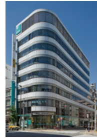
ヒューリック 東上野一丁目ビル
