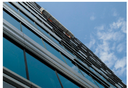
自然換気システム(ヒューリック虎ノ門ビル)
