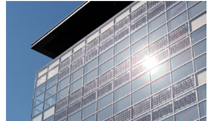
ヒューリック八王子ビル
