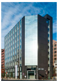
ヒューリック 両国ビル
