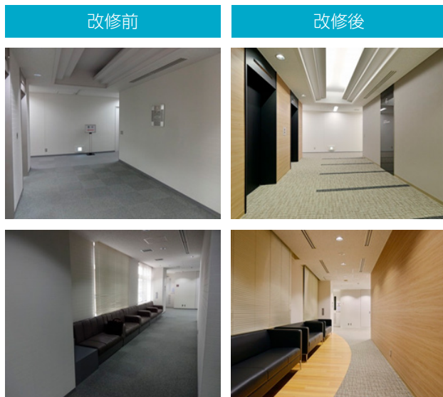
ヒューリック高田馬場ビル：共用部リニューアル工事
