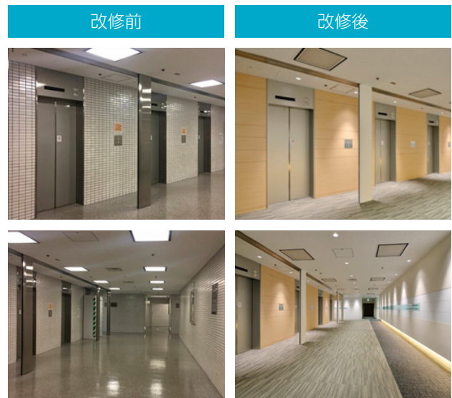
ヒューリック神谷町ビル：共用部リニューアル工事
