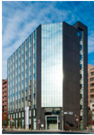
ヒューリック 両国ビル
