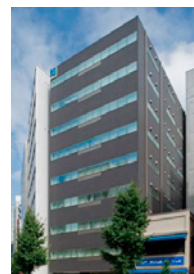
ヒューリック 神田ビル
