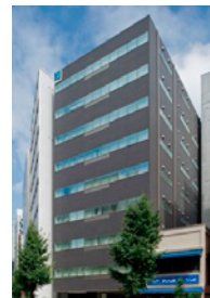
ヒューリック 神田ビル
