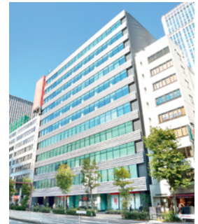
ヒューリック虎ノ門ビル
