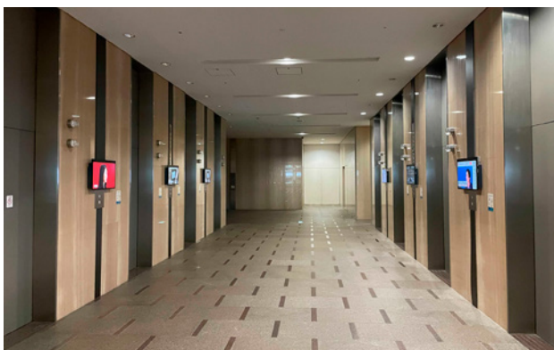
エレベーターホールにテレビモニタを設置
