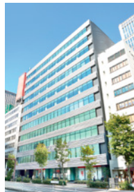
ヒューリック 虎ノ門ビル
