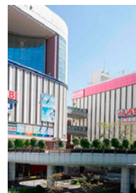
大井町再開発ビル2号棟 大井町再開発ビル1号棟
