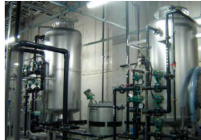
地下鉄湧出水濾過装置設置状況(御茶ノ水ソラシティ)
