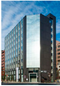
ヒューリック 両国ビル
