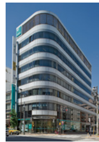
ヒューリック 東上野一丁目ビル
