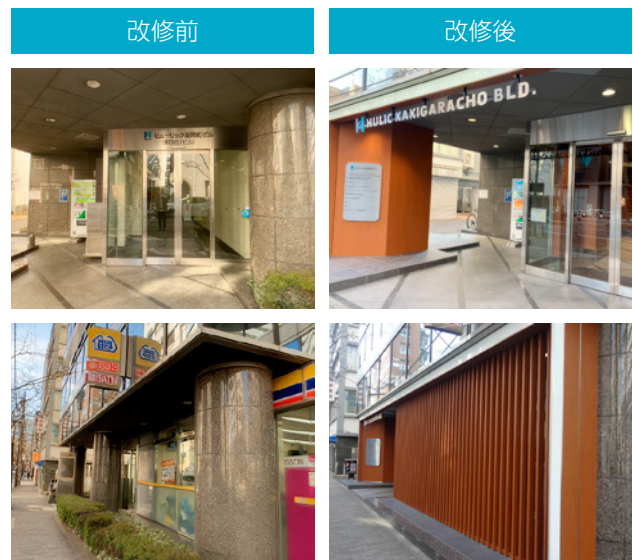
ヒューリック蛸殻町ビル：共用部リニューアル工事
