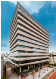
ヒューリック 浅草橋ビル
