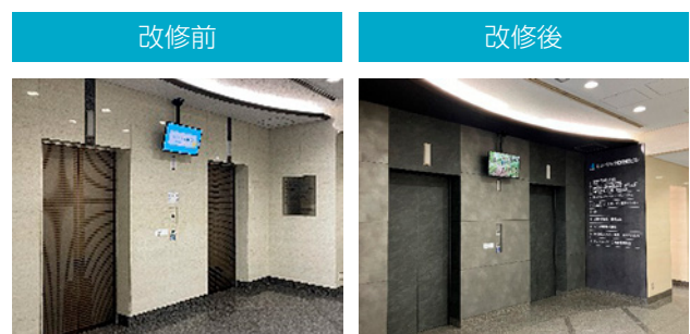
ヒューリック蛸殻町ビル：エントランスリニューアル工事
