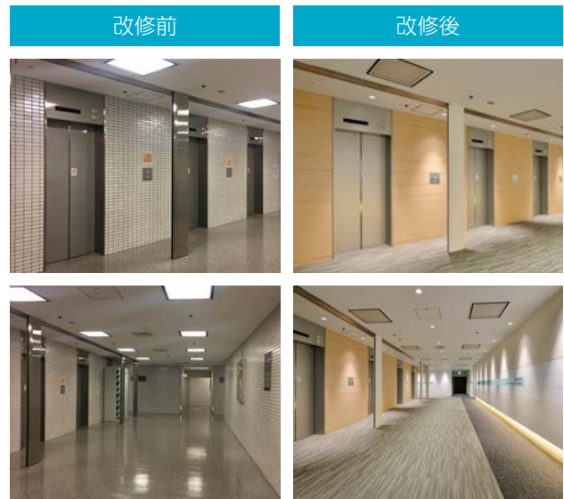
ヒューリック神谷町ビル：共用部リニューアル工事
