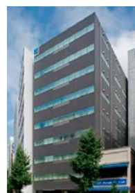
ヒューリック 神田ビル
