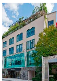
ヒューリック 神宮前ビル
