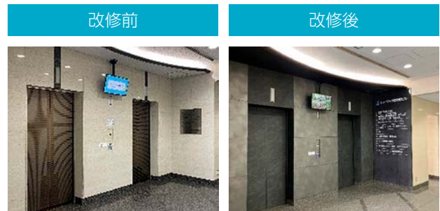
ヒューリック蛸殻町ビル：エントランスリニューアル工事
