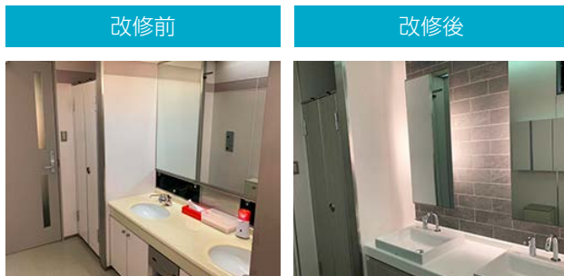
ヒューリック渋谷一丁目ビル：各階トイレリニューアル工事
