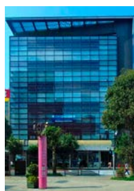
ヒューリック 八王子ビル
