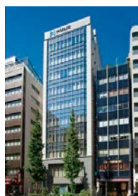
ヒューリック 神田橋ビル
