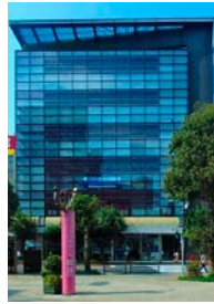
ヒューリック 八王子ビル
