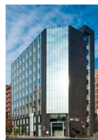
ヒューリック 両国ビル
