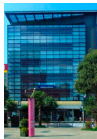
ヒューリック 八王子ビル
