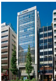
ヒューリック 神田橋ビル
