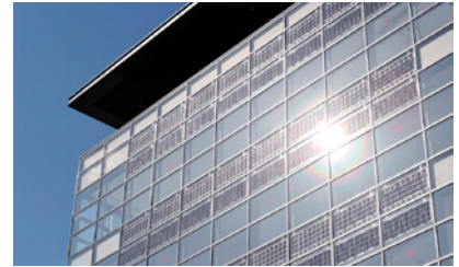
ヒューリック八王子ビル
