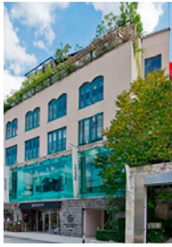
ヒューリック 神宮前ビル
