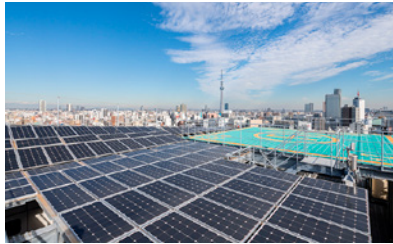
ヒューリック浅草橋ビル
