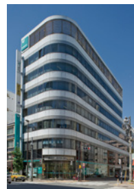
ヒューリック 東上野一丁目ビル
