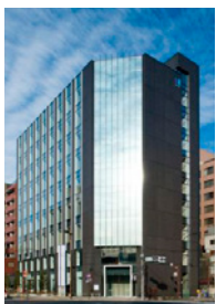
ヒューリック 両国ビル
